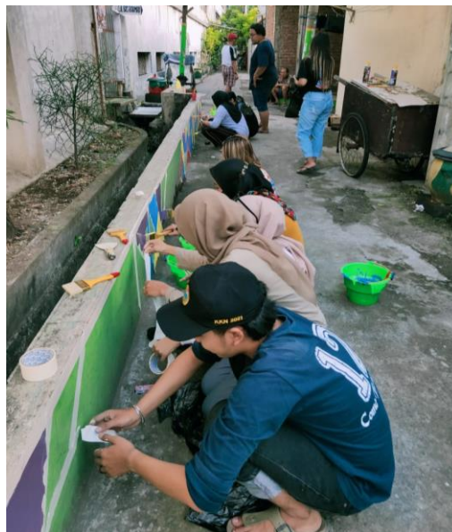
Gambar 5 : Pengecatan dinding got.
