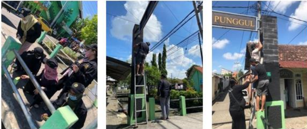
(Gambar 3. Kegiatan pengecatan gang dan jembatan)
