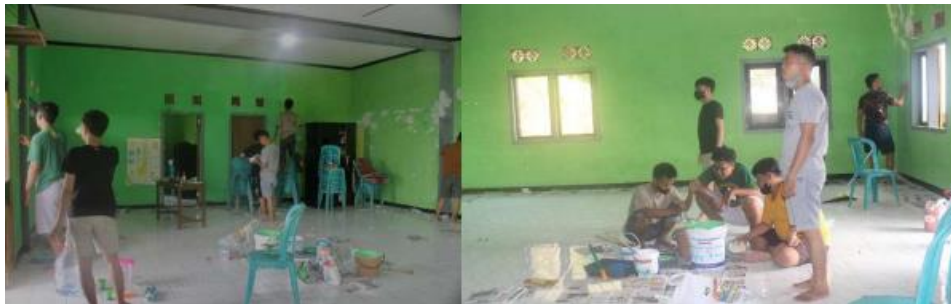
Gambar 3. Pelaksanaan Pengecatan Balai Dusun
