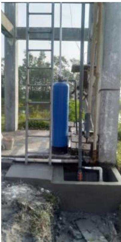
Gambar 12. Hasil Akhir Filter Air dan Perbaikan Tower
