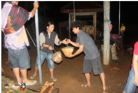
Gambar 10 Proses pengecoran tiang
