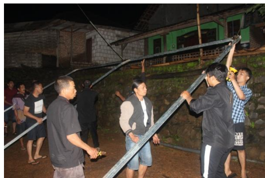
Gambar 9 Proses pemasangan tiang peyangga
