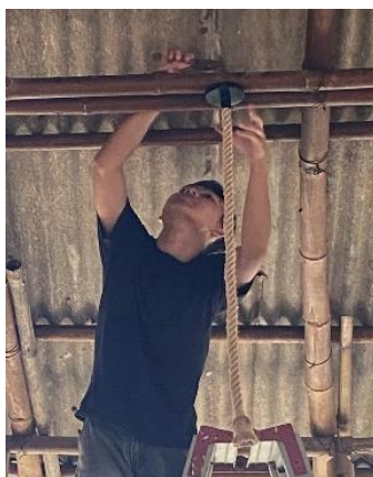
Gambar 6. Perbaikan dan Pembersihan Lokasi Budidaya Jamur
