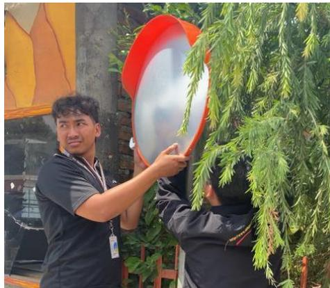
Gambar 5. Pemasangan Safety Mirror
