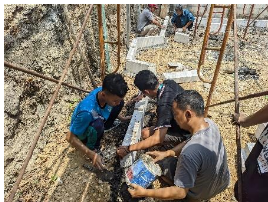
Gambar 8. Proses Pembangunan Taman TOGA
