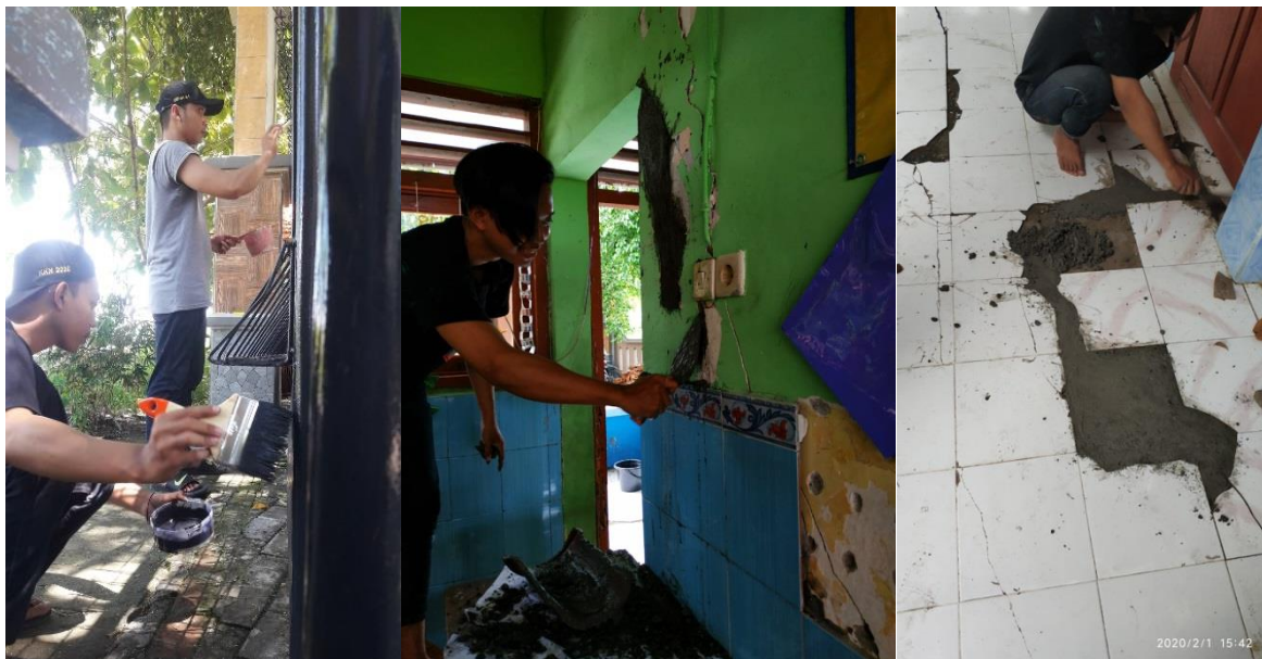
Gambar 5. Pengecatan dan perbaikan sarana dan prasarana SDN Canggih
