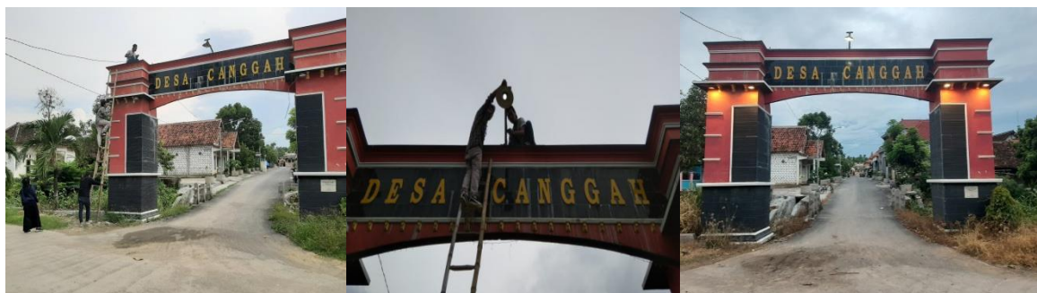
Gambar 7. Renovasi Lampu Gapura Pintu Masuk Desa Canggah
