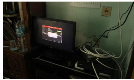
Gambar 10. Hasil pemasangan hd-dvr
