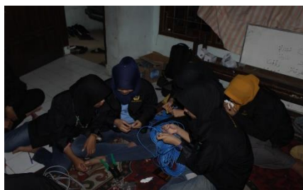
Gambar 1. Pemasangan rj-45 ke kabel lan
