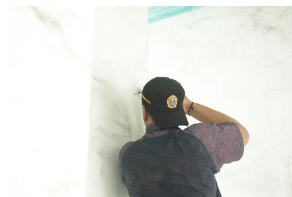
Gambar 7. Pemasangan cctv outdoor
