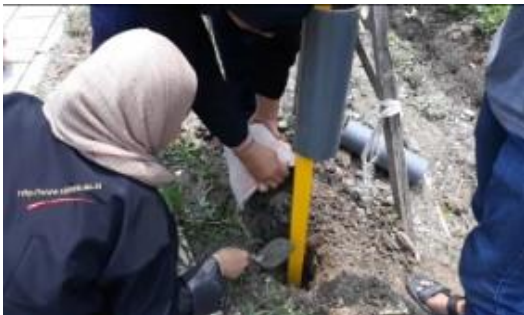
Gambar 8. Penancapan tiang dengan pipa dilakukan setelah penggalian lubang.
