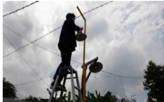
Gambar 13. Pemasangan fitting lampu dilakukan oleh anggota kelompok
